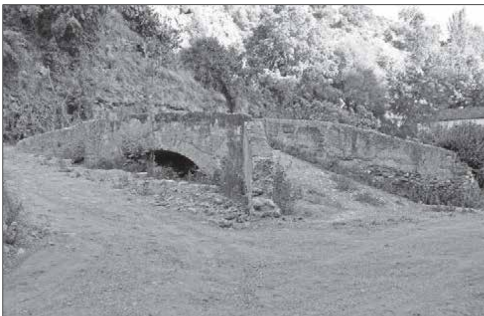
El Puente Medieval de Dúrcal.
