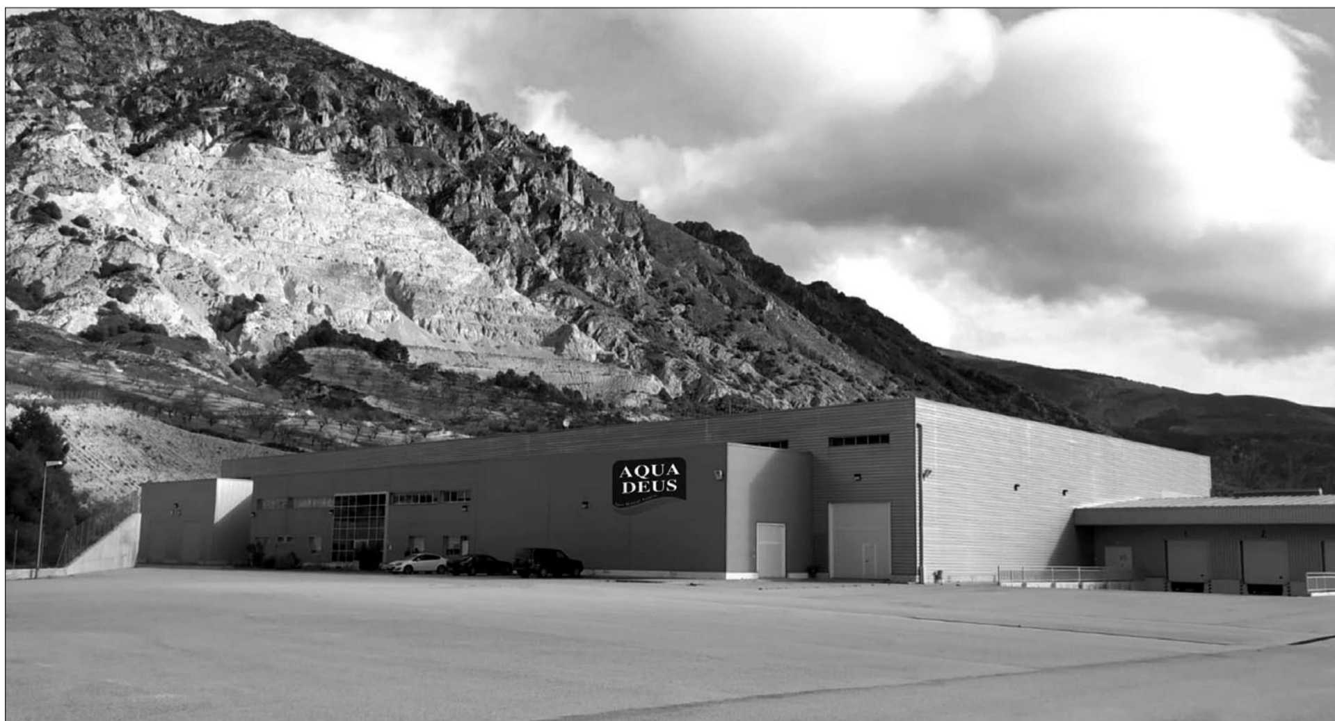
Embotelladora de agua de Dúrcal.
